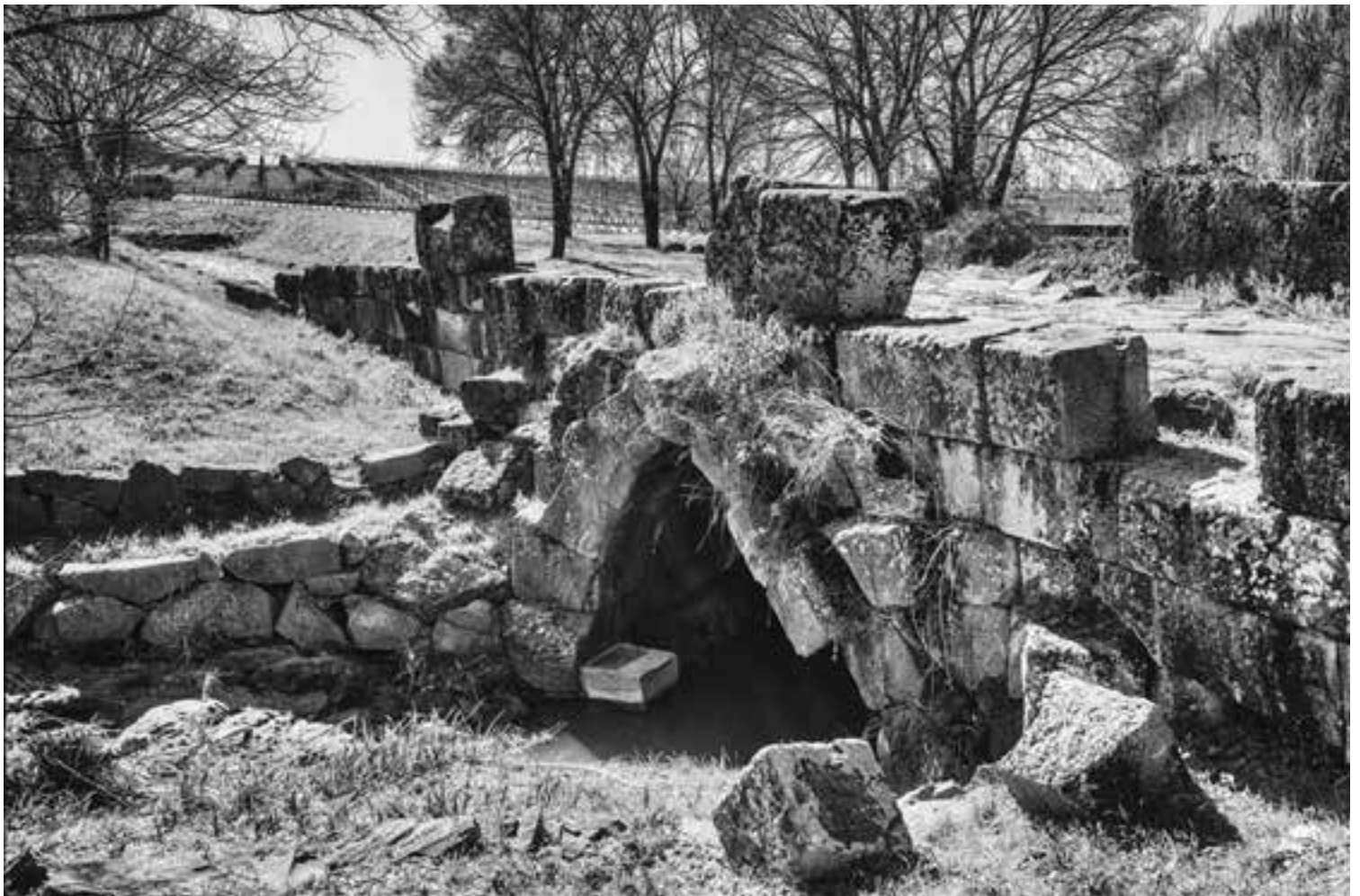
1. Ponte di età romana detto Loreto (II-I sec. a.C.)
