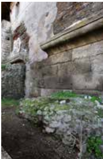
5. Particolare di un tratto del muro della scena del teatro romano
